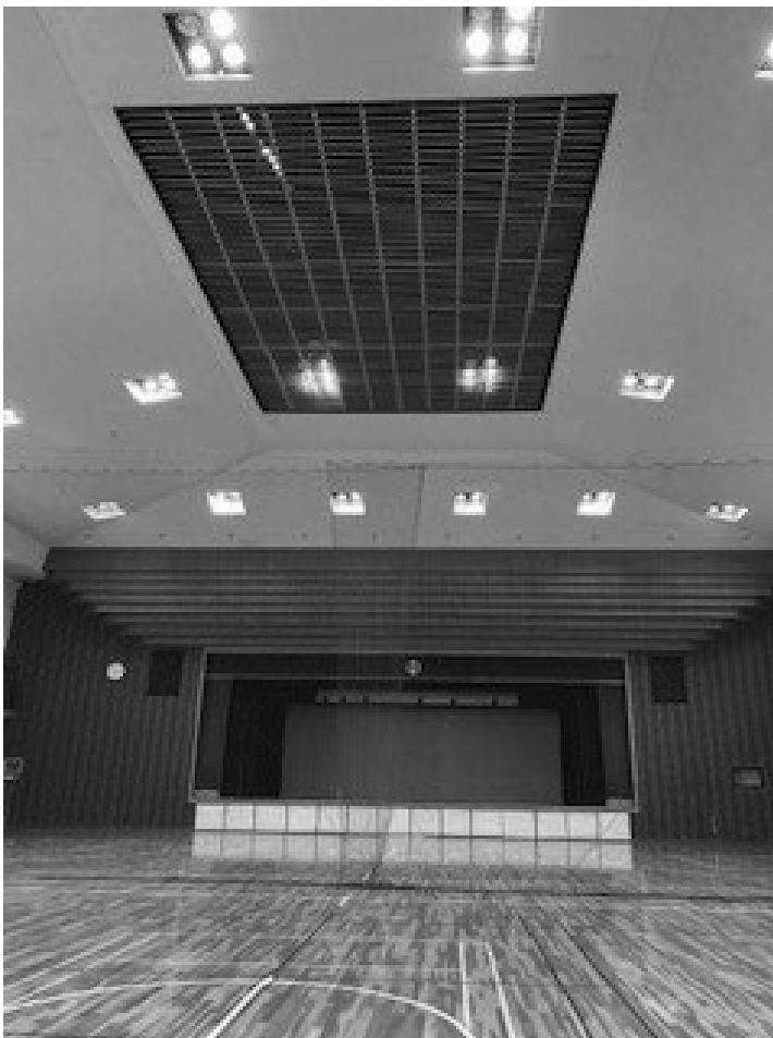
扶桑町総合体育館内第1競技場の状況
