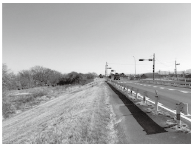
(仮称)新愛岐大橋が接続される 県道浅井犬山線・小渕交差点付近
