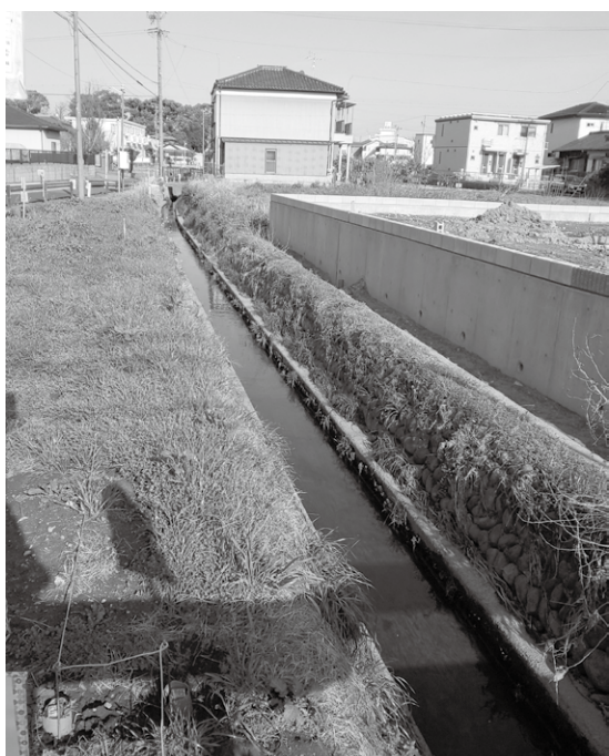
青木川改修計画区域予定地
