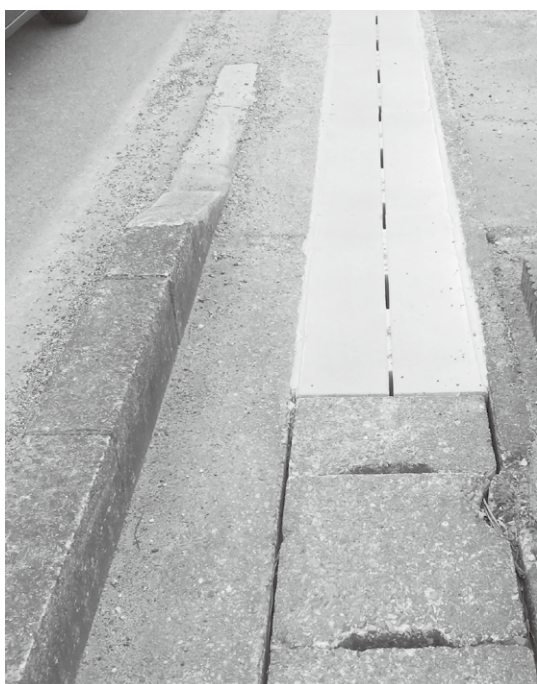
手前の従来型側溝蓋と改修したスリット蓋
