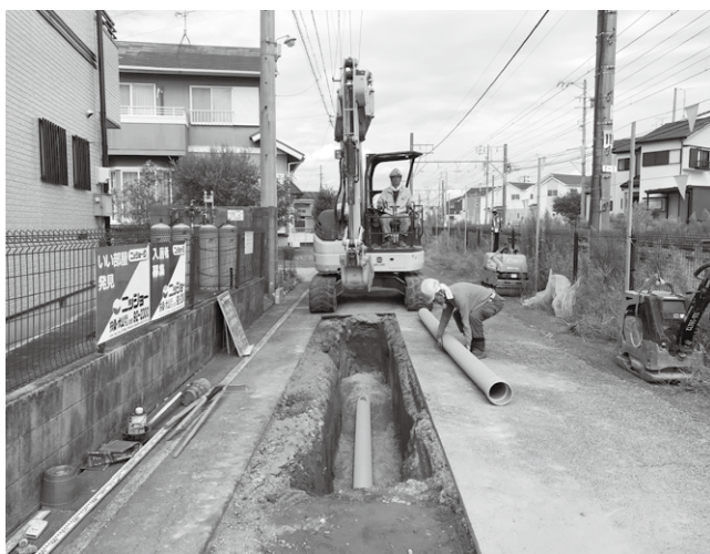
道路占用工事(下水道)
