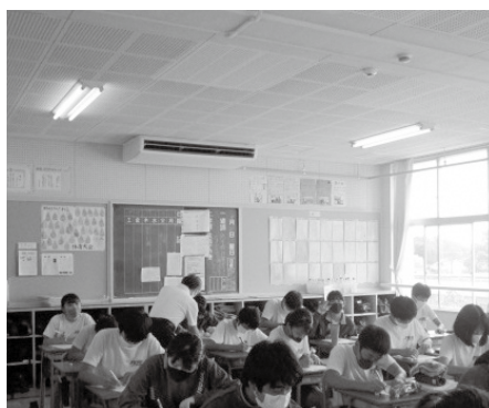
町内各中学校 エアコン設置
