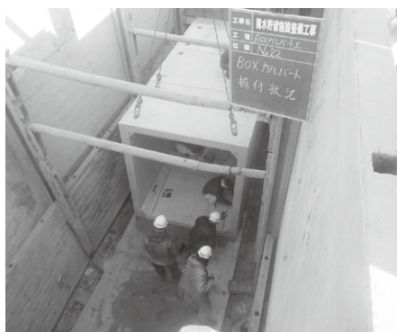
斎藤 座敷野地内雨水貯留施設
