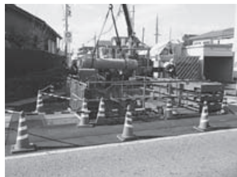
高雄字定松郷地内の下水道工事
