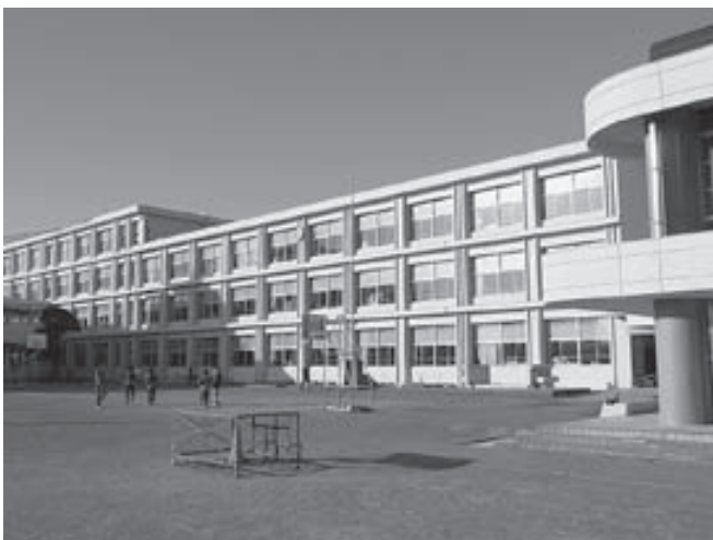
平成30年度にエアコン設置工事が 予定される柏森小学校
