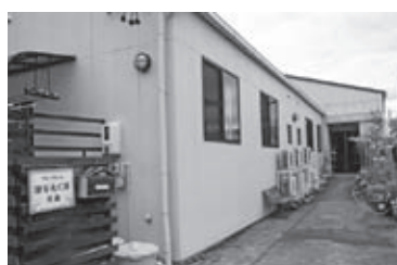
スプリンクラーが設置されるグループホーム
