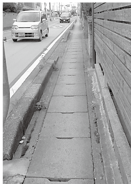
(側溝上の歩道)
