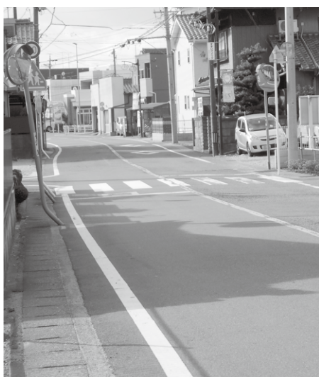
(柏森駅前道路の状況)
