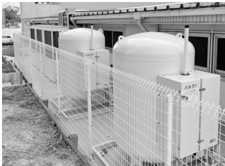
(大府市に設置されたL P ガス災害バルク)
