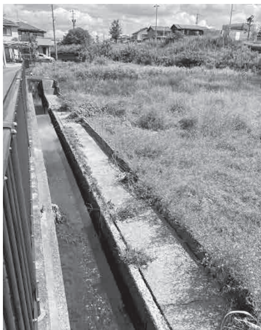
(巾下用排水路「上流域」)
