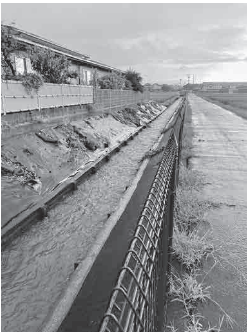
(竪井堀用排水路)
