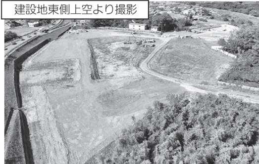
雨水調整池の整備状況
