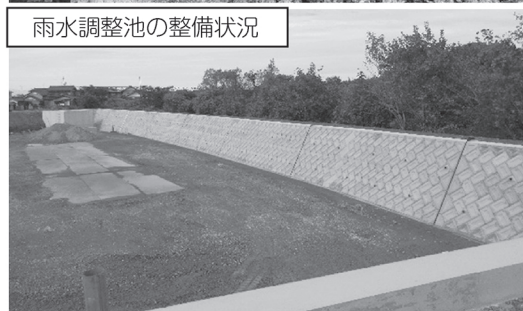
建設地の状況（令和6年10月末時点）
