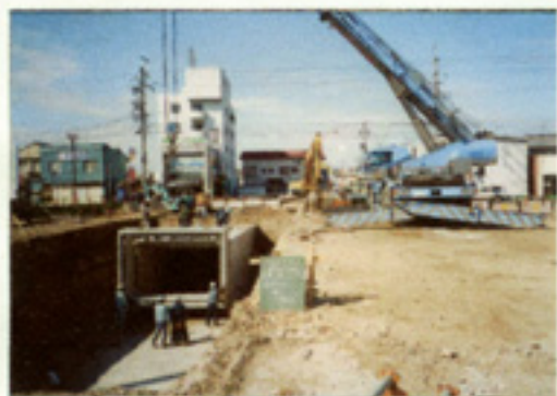
柏森駅北広場地下貯留槽 (平成15年度完了)
