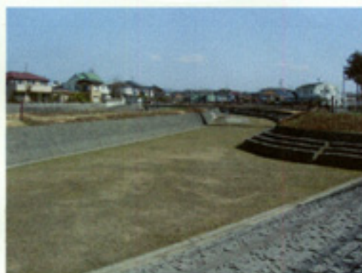
青木川中島調節池 (平成8年度完了)
